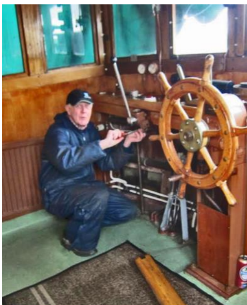
Håkan Rutgersson jobbar med en styrventil
