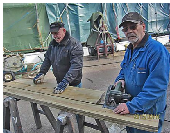
Hans Hartman och Henrik Back sågar till virke till en ny lastlucka till Polstjärnan.
