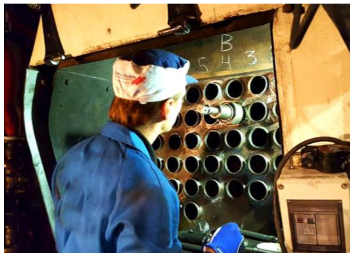
Inpressning i panngaveln pågår.
