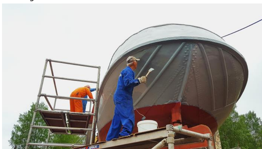
Arbetena har påbörjats.
