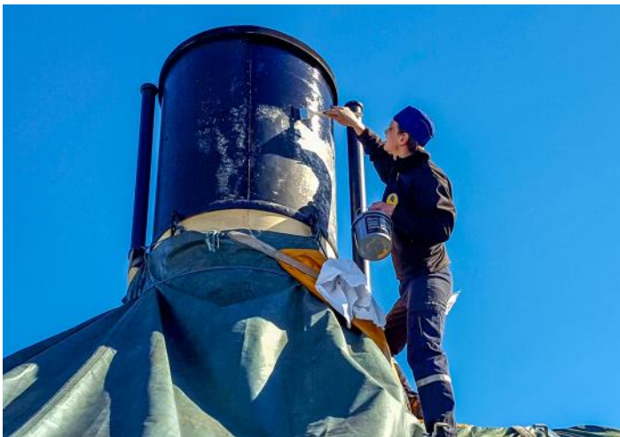
Polstjärnans skorstenstopp målas.
