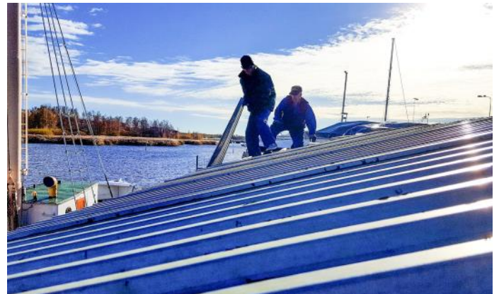
Plåten läggs på.
