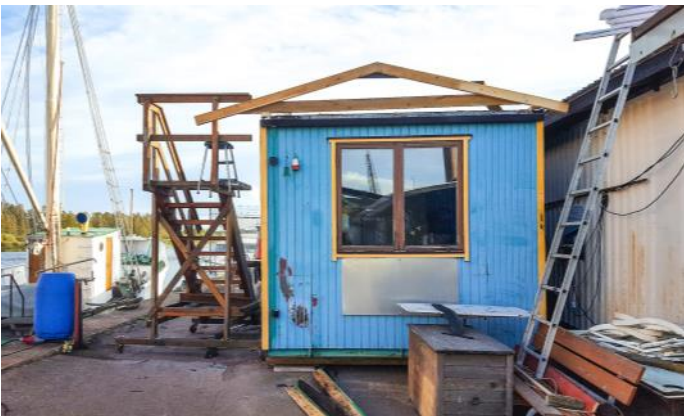
Takstolarna monterade.
