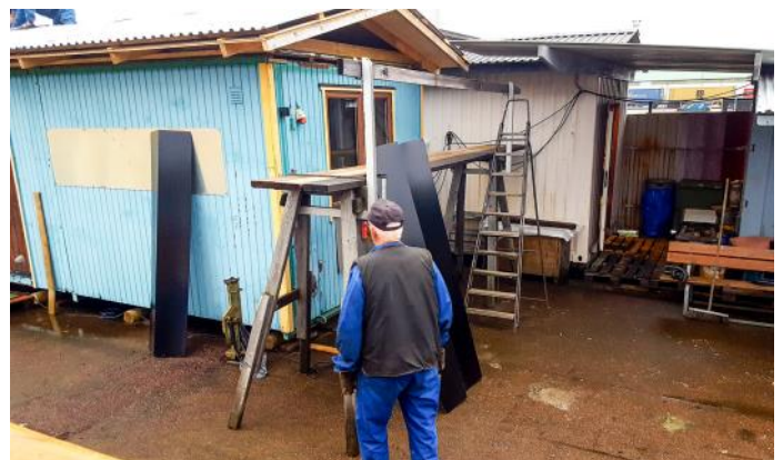
Stugan nästan färdig. "Bara" inredningen återstår.
